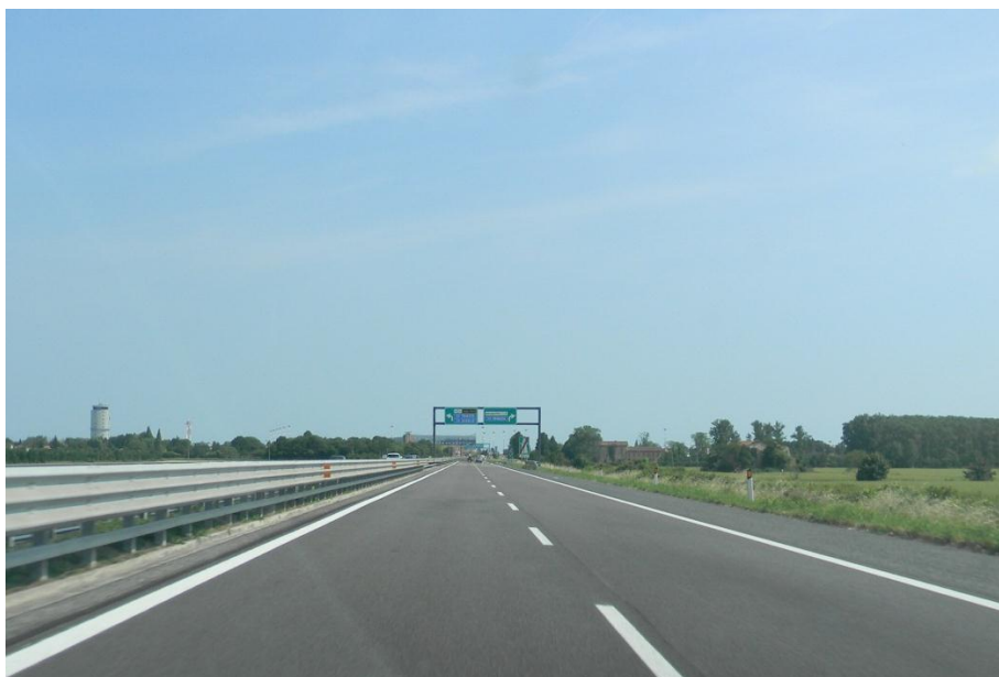
Figura 2.12: Raccordo Autostradale per l'Aeroporto Marco Polo
