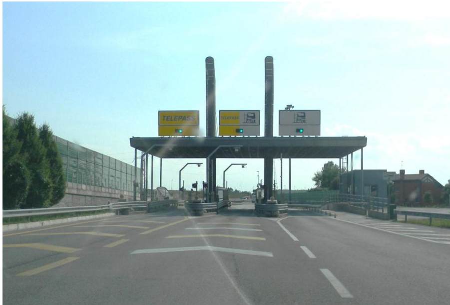
Figura 2.2: A4 Passante di Mestre – svincolo di Spinea
