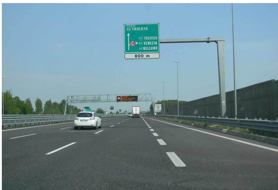
Figura 2.4: A4 Passante di Mestre – Interconnessione A27
