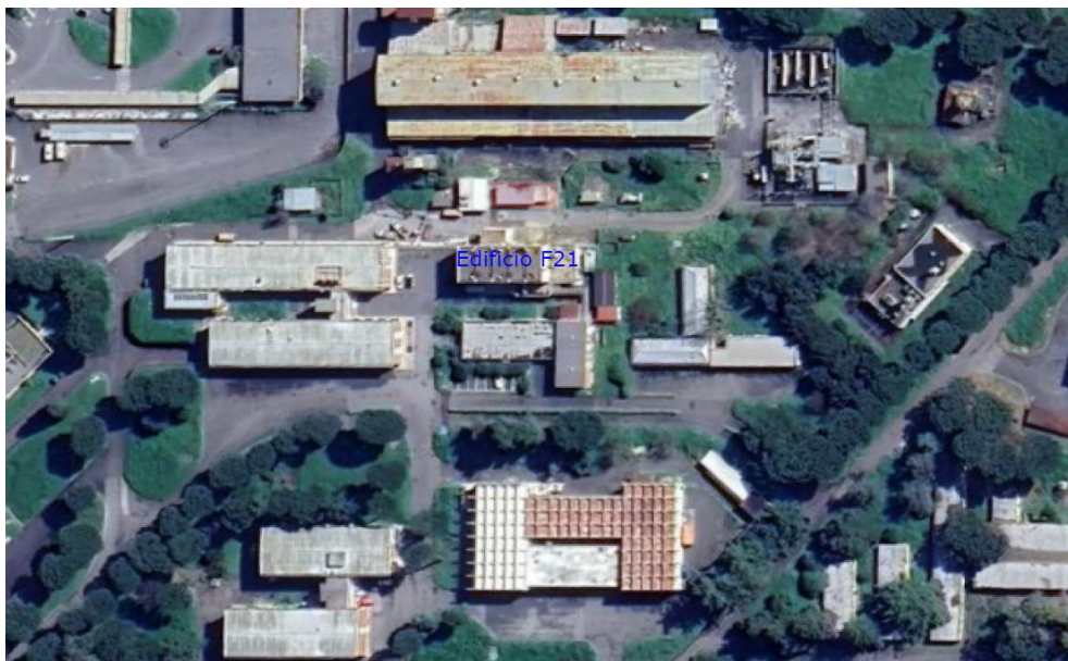
Edificio F21 e sito di installazione container
