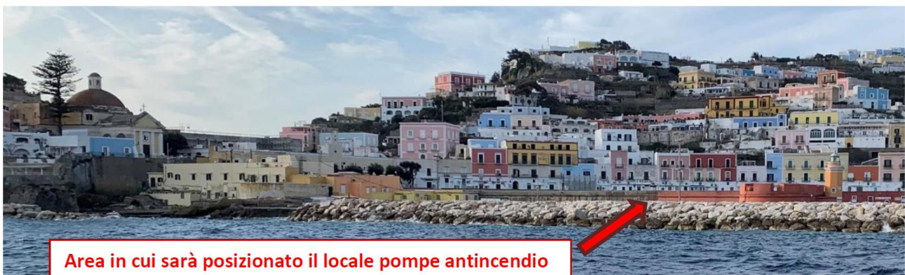
Vista dal mare dell'area interessata da interventi
