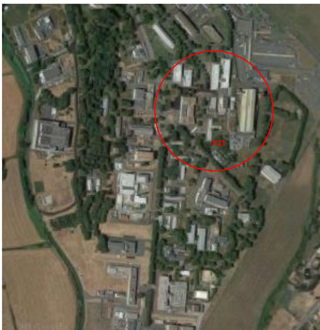
Figura 2- Edificio F21 e sito di installazione container
