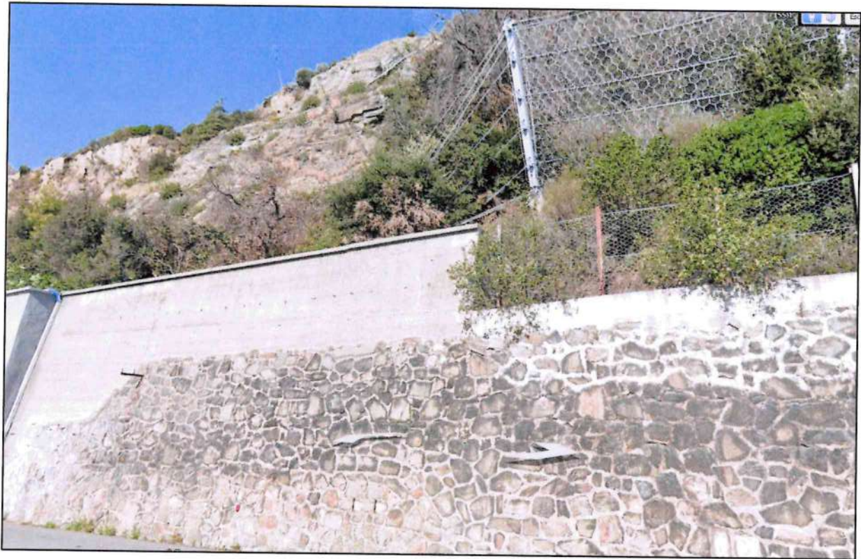
Fig. 3 Punto da cui partire con la nuova rete paramassi posizionata a monte del Muro esistente tratto compreso tra il km 547+650 ed il 547+900 circa
