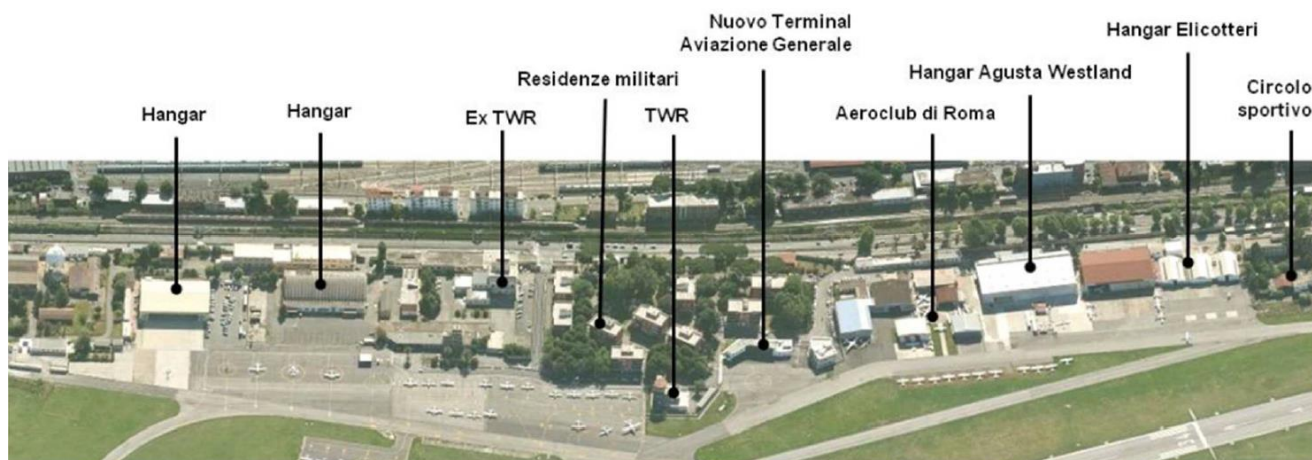
Successione degli edifici lungo il lato parallelo a via Salaria
