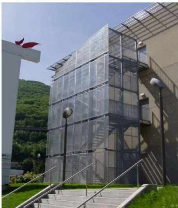
Figura 1: Riferimento architettonico scala antincendio rivestita in lamiera stirata
