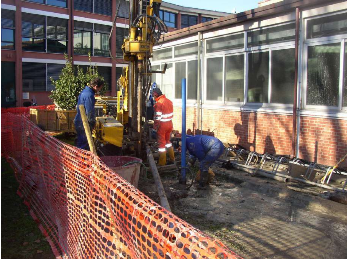
Panoramica dell'ubicazione del sondaggio S1 presso l'Università di Pisa Facoltà di Ingegneria
