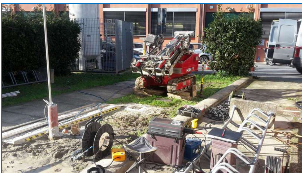
Viste del cantiere della prospezione downhole con la disposizione della strumentazione
