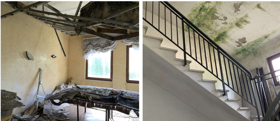
Figura 17: Controsoffitto crollato e tracce di umidità visibili all'interno del manufatto.
