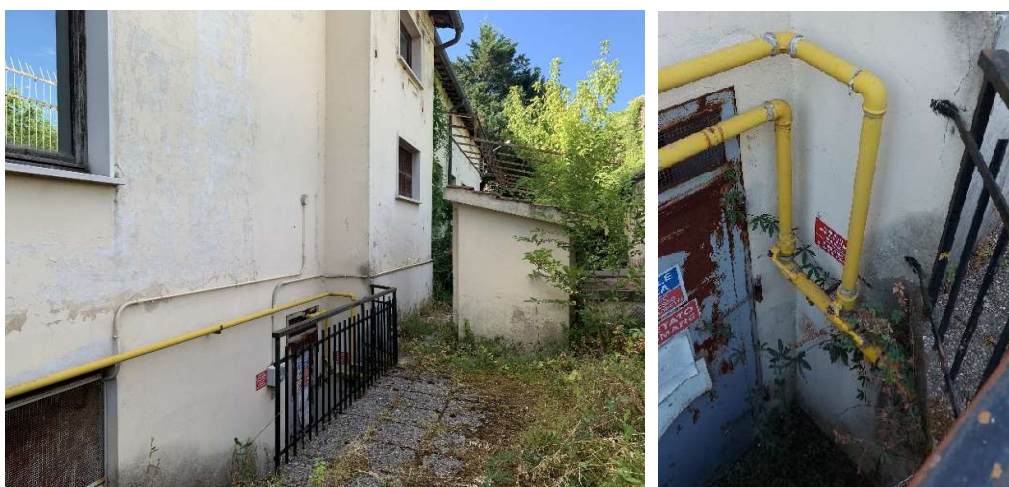
Figura 47: Vista 26, la tubazione del gas verso la cucina e la centrale termica.
