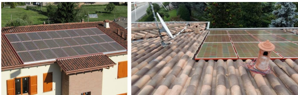
Figura 1: vista dall'alto e vista ravvicinata di impianto fotovoltaico integrato nel piano di copertura, color cotto
