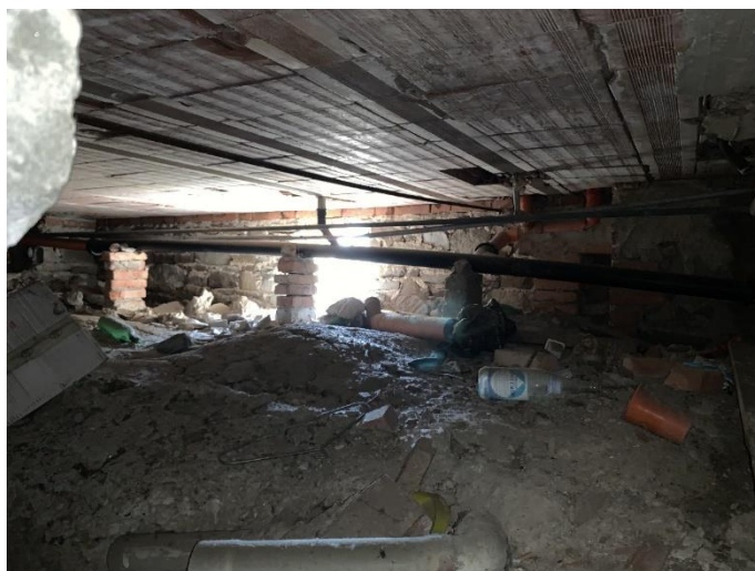
Figura 41: Vista 20, l'intercapedine tra solaio del piano terra e fondazione, da una finestra del corridoio al piano interrato.
