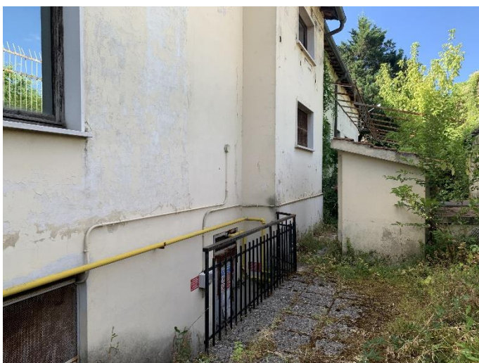
Figura 47: Vista 26, la tubazione del gas verso la cucina e la centrale termica.
