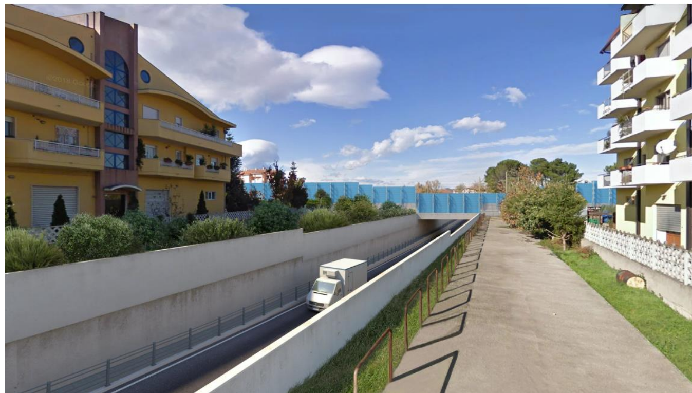
Figura 6-9 - Ante operam. Sottopasso stradale dei Mille
