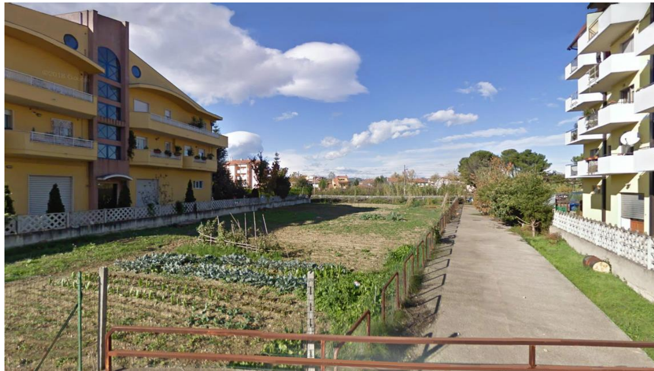
Figura 6-8 - Ante operam. Sottopasso stradale dei Mille
