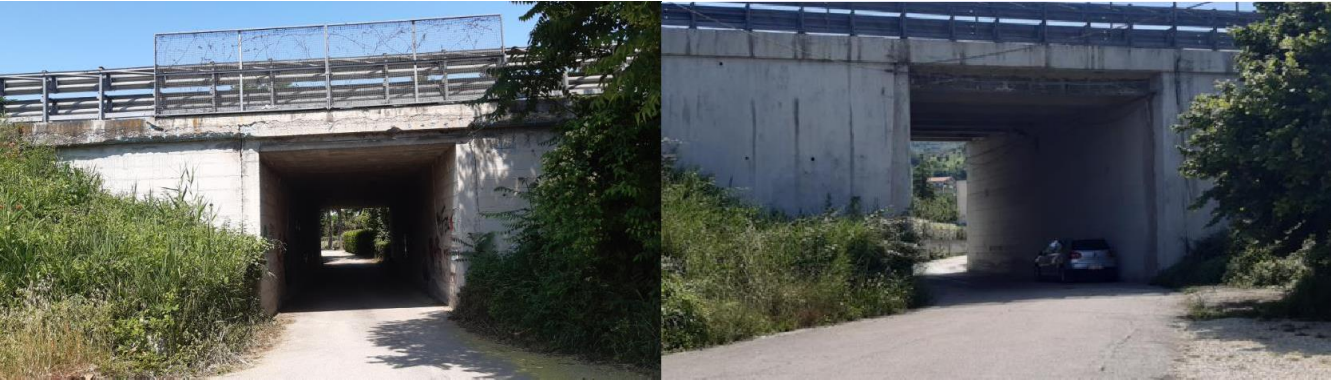
Figura 6-33 - Sottopassi di via Salinello e di via Vibrata
