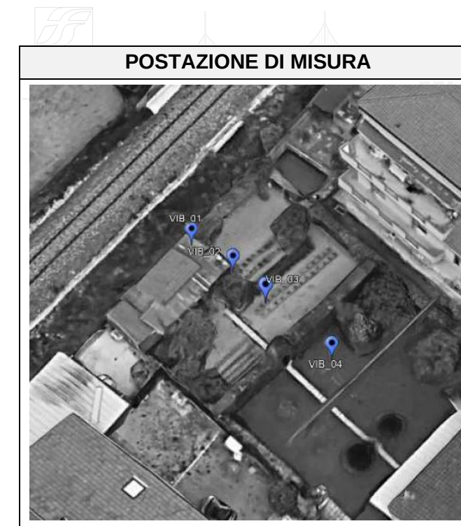
Figura 6-10: Localizzazione delle indagini vibrazionali lungo l’attuale linea ferroviaria Roma-Pescara
