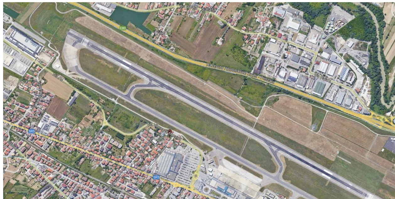
Figura 4-9 - Foto aerea dell'area di intervento
