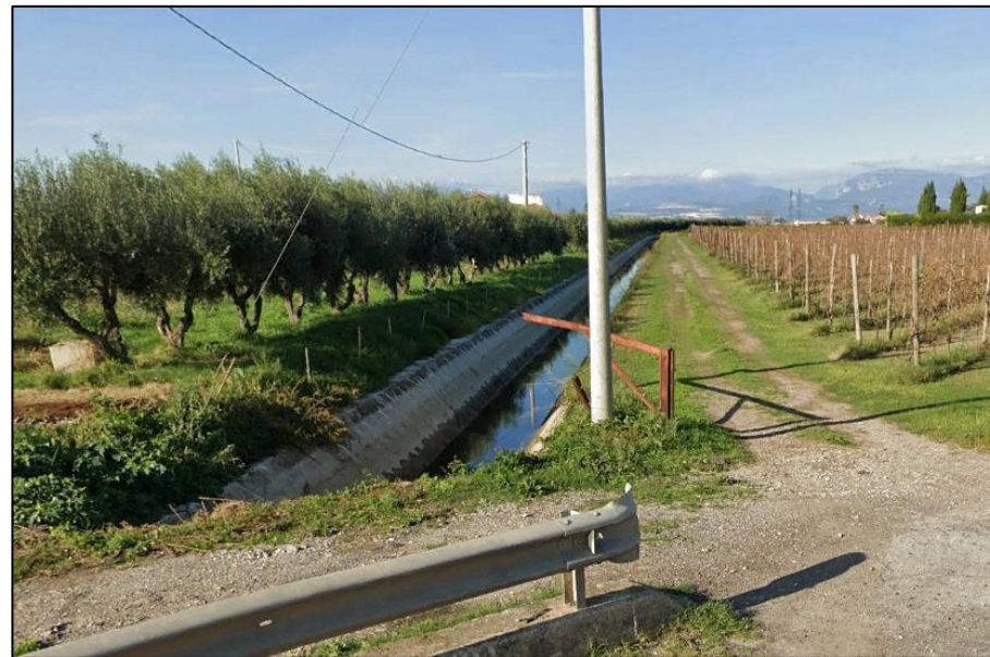
Figura 13 - Diramatore principale visto dalla SP316B.
