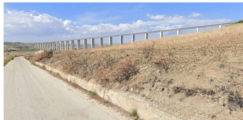
Figura 3 12 - Alternativa 2A raddoppio in quota Viadotto Carboj
