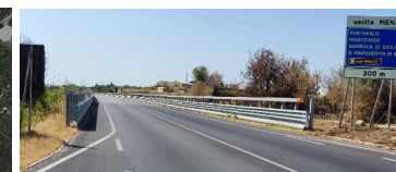
Figura 3-5- Barriere di sicurezza
