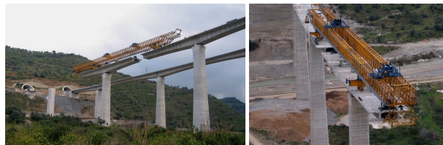
Figura 3-13 – Alternativa 2A e 2B – Esempio di carro varo sull'autostrada Messina – Palermo
