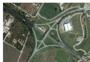
Figura 3-6- Svincolo di Menfi
