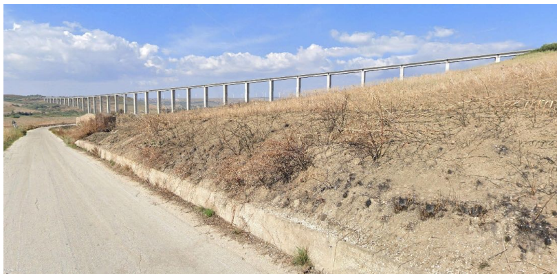
Figura 3 11 - Stato attuale Viadotto Carboj
