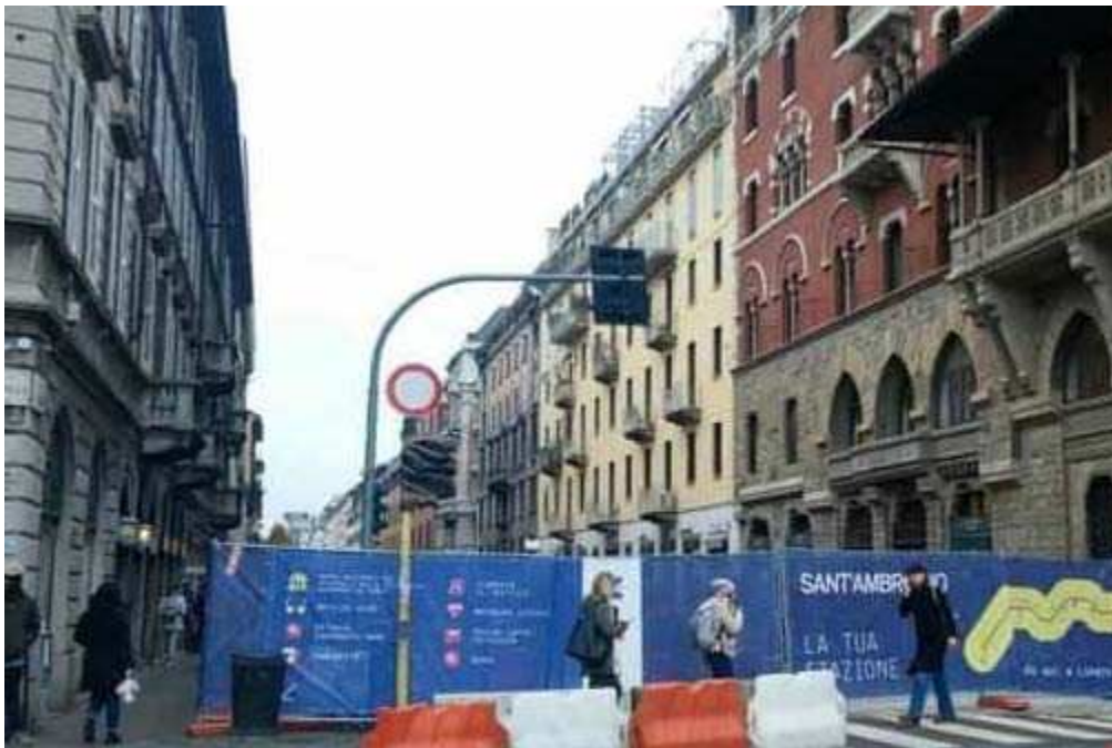
Figura 35_descrizione dei lavori in corso
