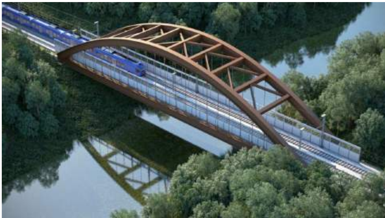
Foto: ponte ferroviario di 100 metri di luce netta sul fiume Brenta.
