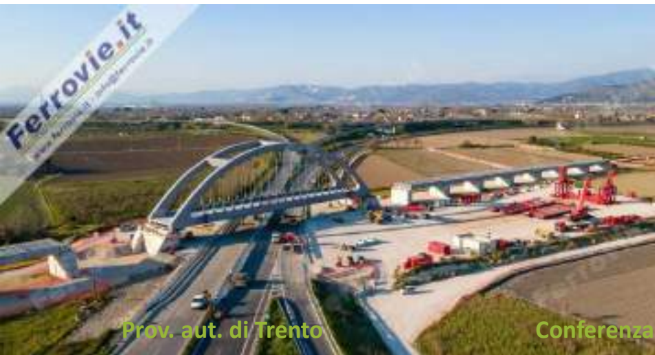
Ponte ferroviario lotto Afragola - Cancellò della costruenda linea AV/AC Napoli – Bari, 80 metri di luce netta
