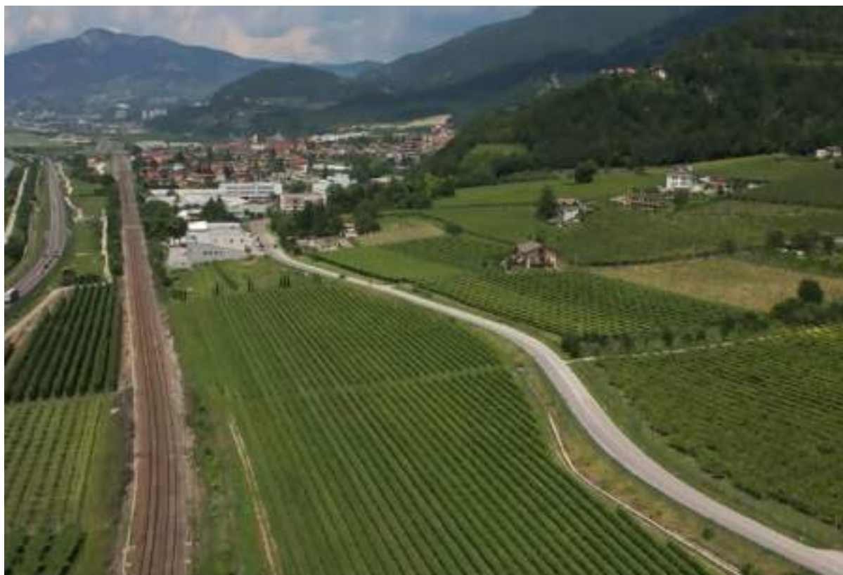
Foto: la situazione attuale a Acquaviva dove vi sarà l'ingresso della galleria della Circonvallazione Ferroviaria per l'Alta Capacità.
