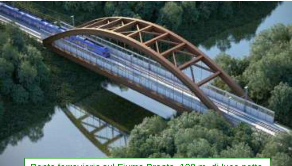
Ponte ferroviario sul Fiume Brenta, 100 m. di luce netta
