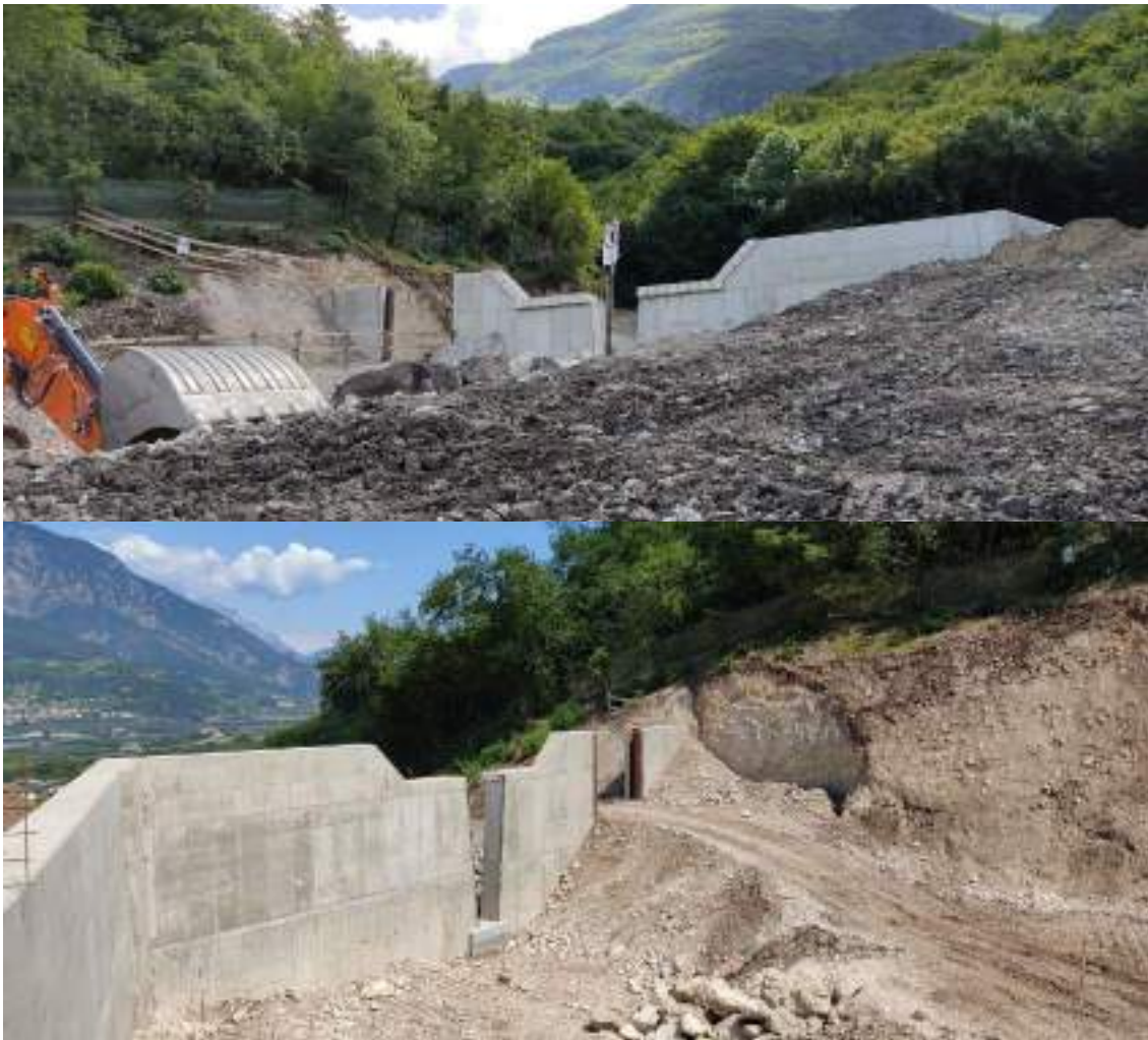
Intervento dei Bacini Montani- primavera 2021. Uno degli invasi in via di costruzione sul rio Scanuppia
