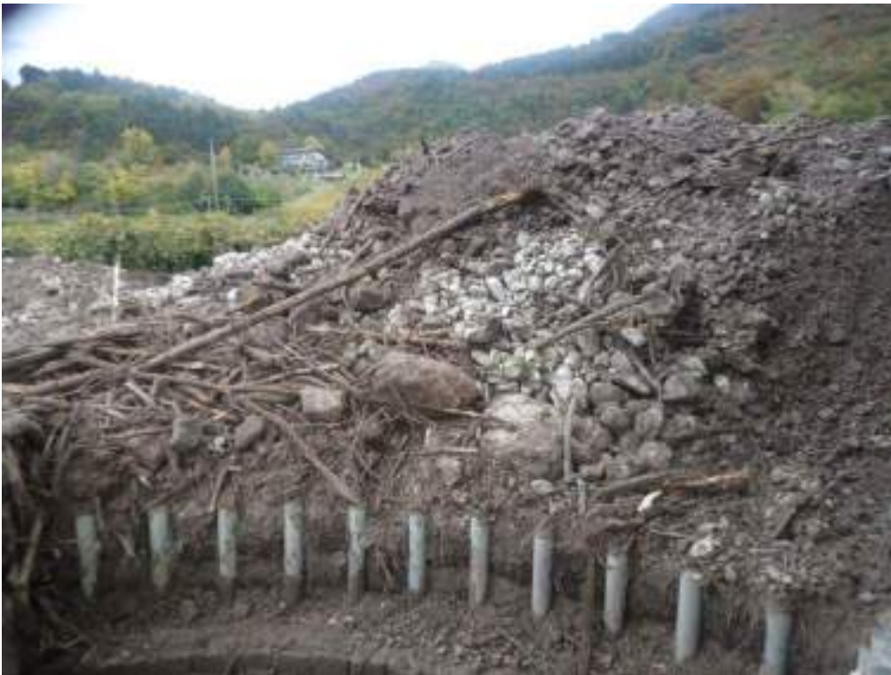
Figura 2 Vecchio invaso del rio Scanupia- ottobre 2018
